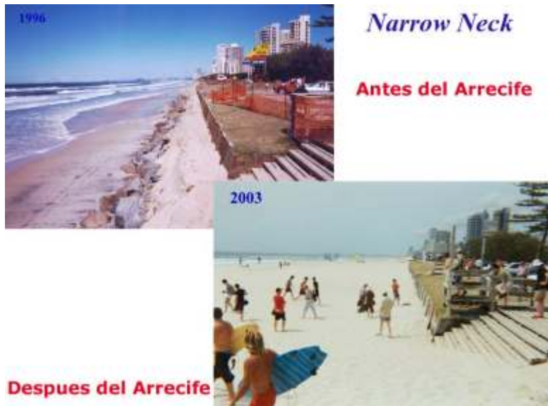
Figura 3 Demostración del suceso del arrecife artificial en Narrowneck. La energía de la ola fue disipada en un 90% y el arrecife se convirtió en un punto de control de la erosión costera en la costa.
